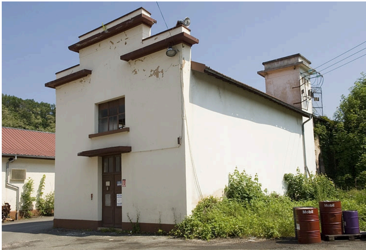
Ancien bâtiment d'eau et transformateur.
