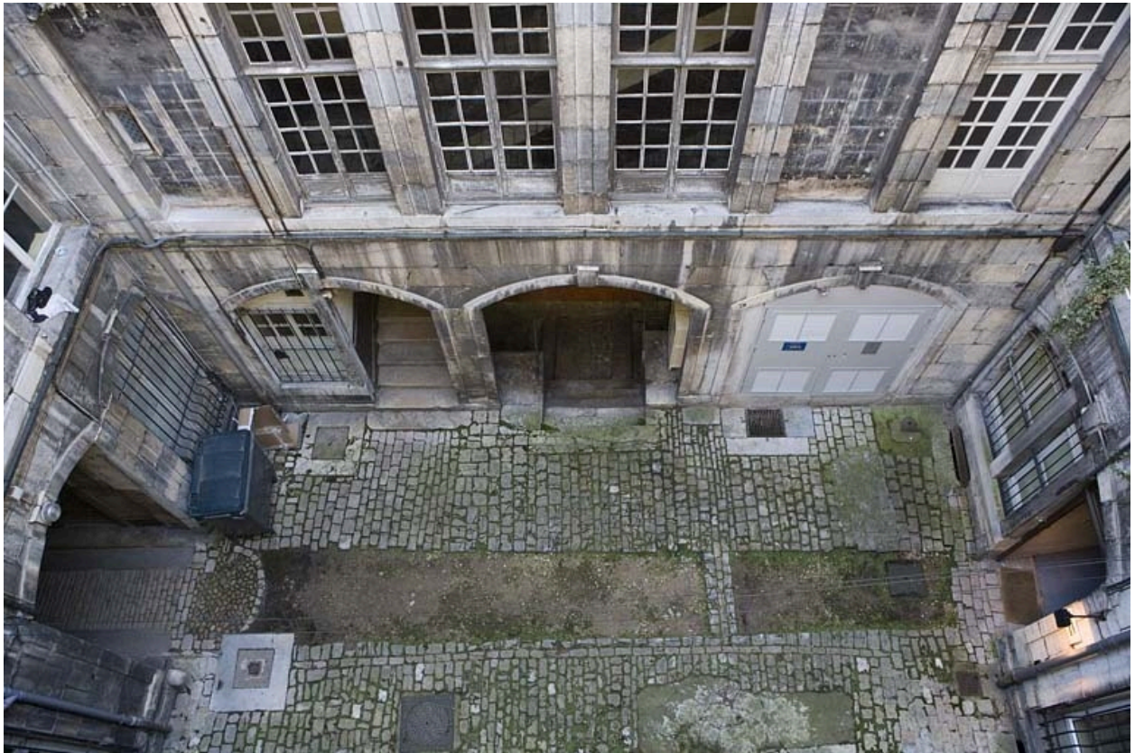
Aile gauche dans la première cour : détail du rez-de-chaussée, vue en plongée.
