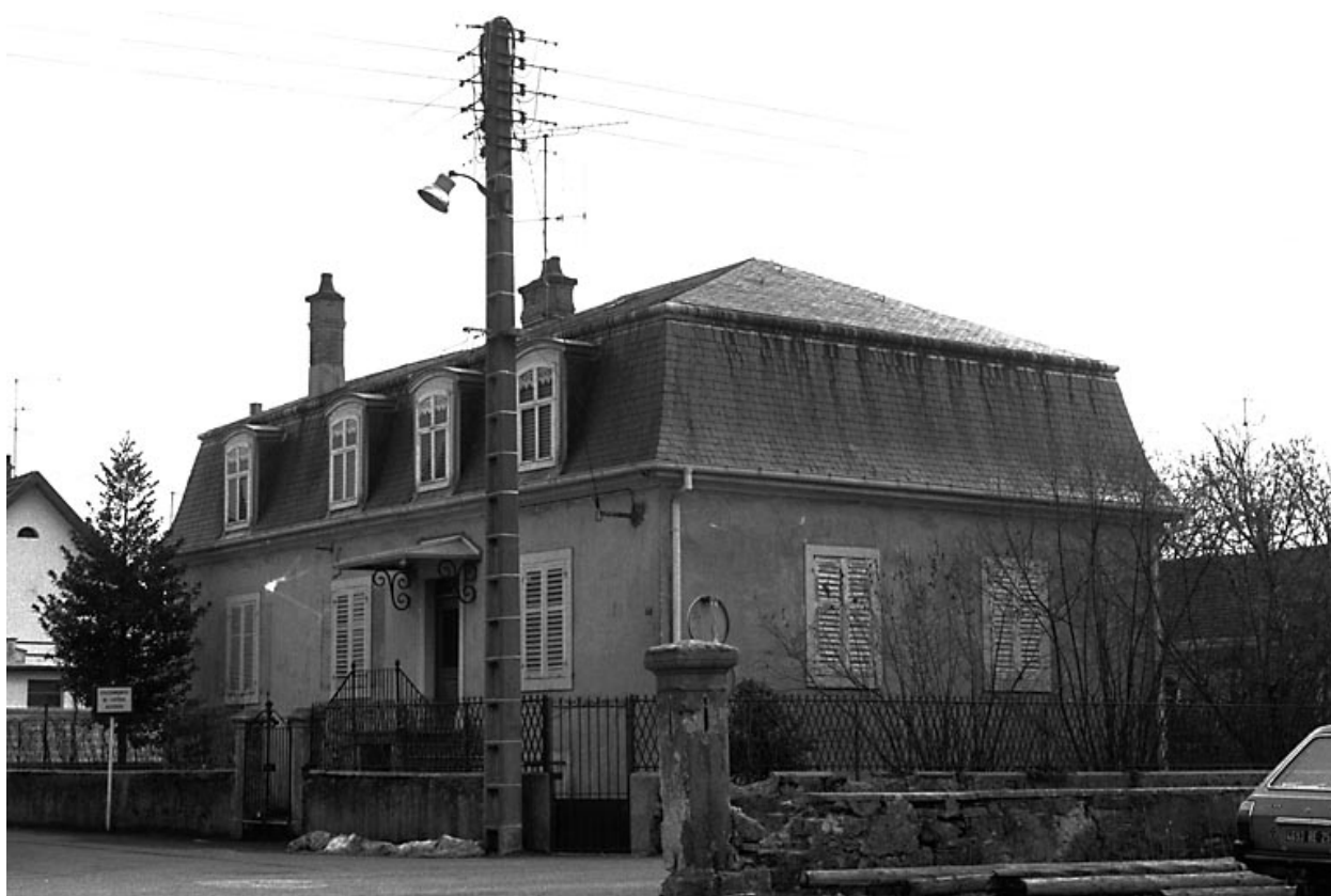
Audincourt : maison située 7 rue du Château.
