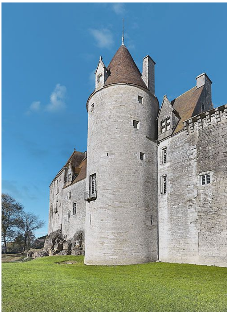
Vue du château de Châteauneuf, tour de la face sud des remparts.
