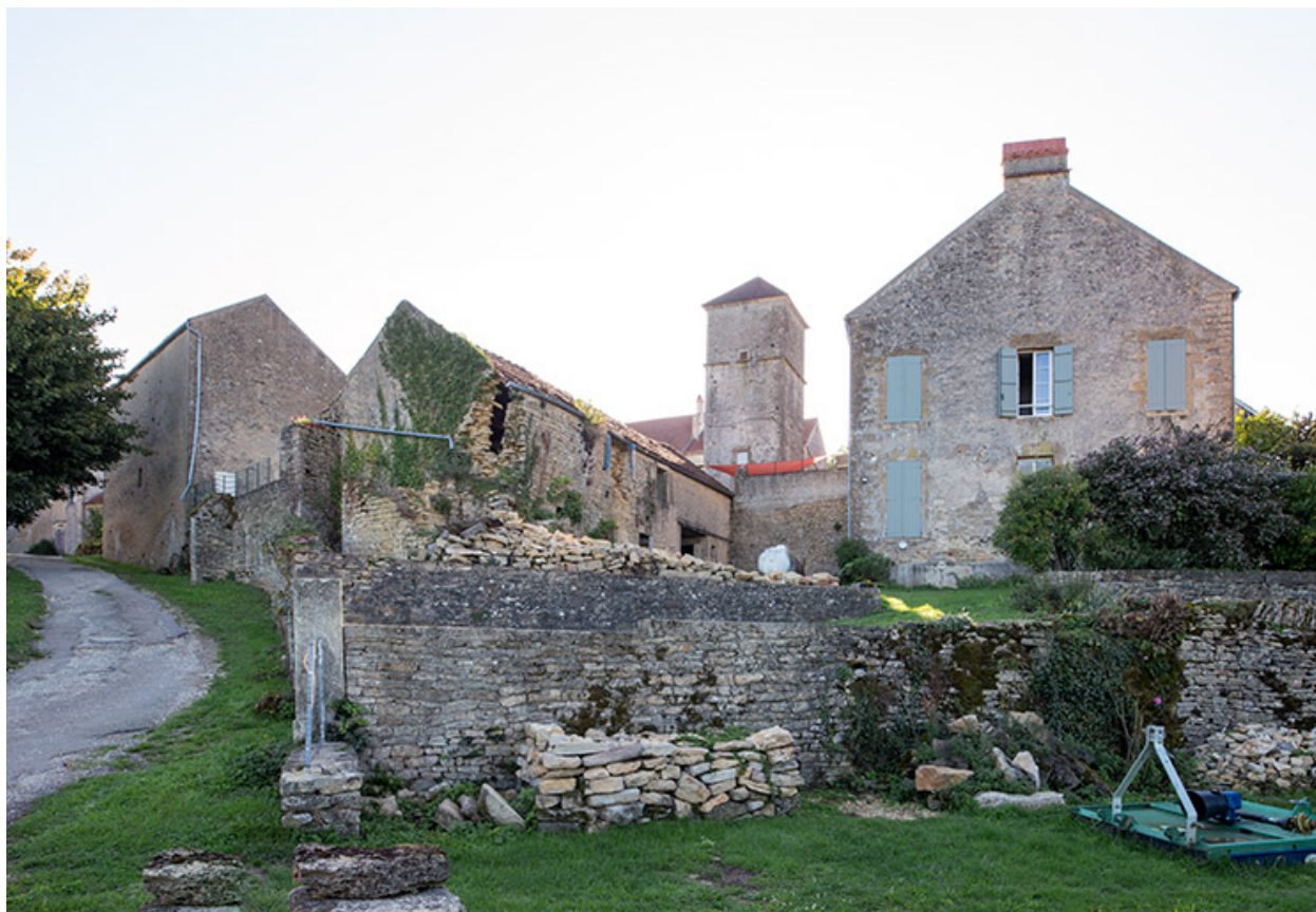
L'ensemble du site vu de l'ouest, depuis la rue de la Bergerie.
