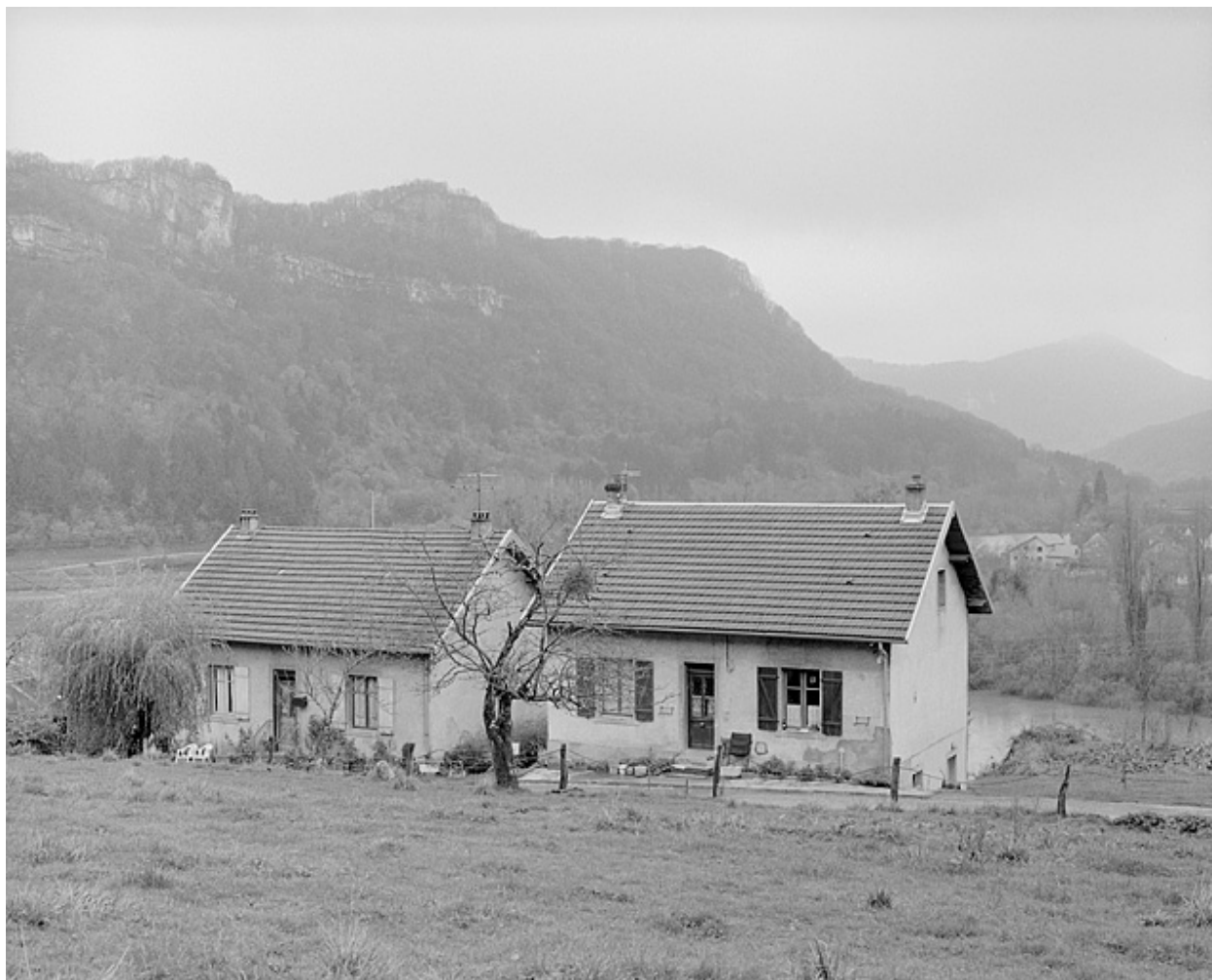
Vue d'ensemble des logements ouvriers individuels.
