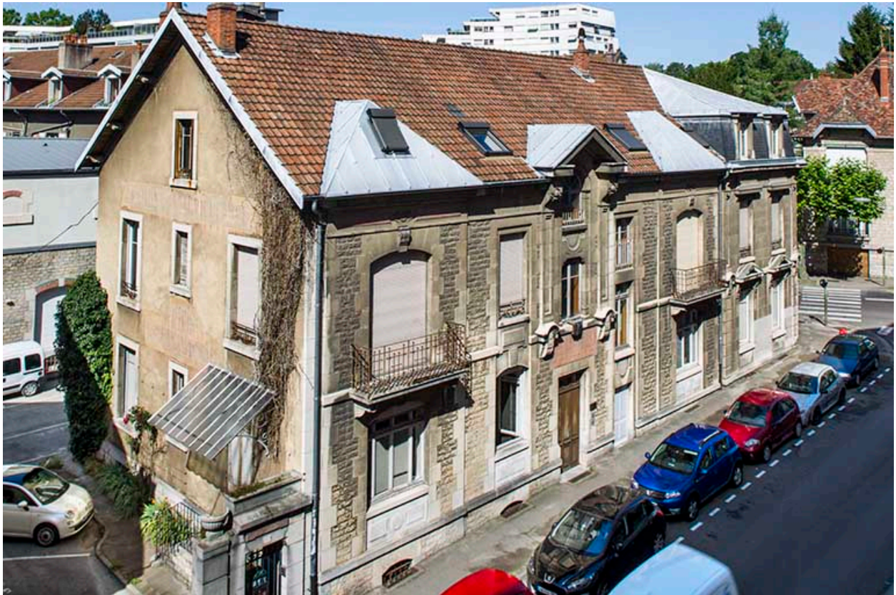
Bâtiment de l'administration : vue plongeante sur la façade antérieure (côté rue Delavelle).
