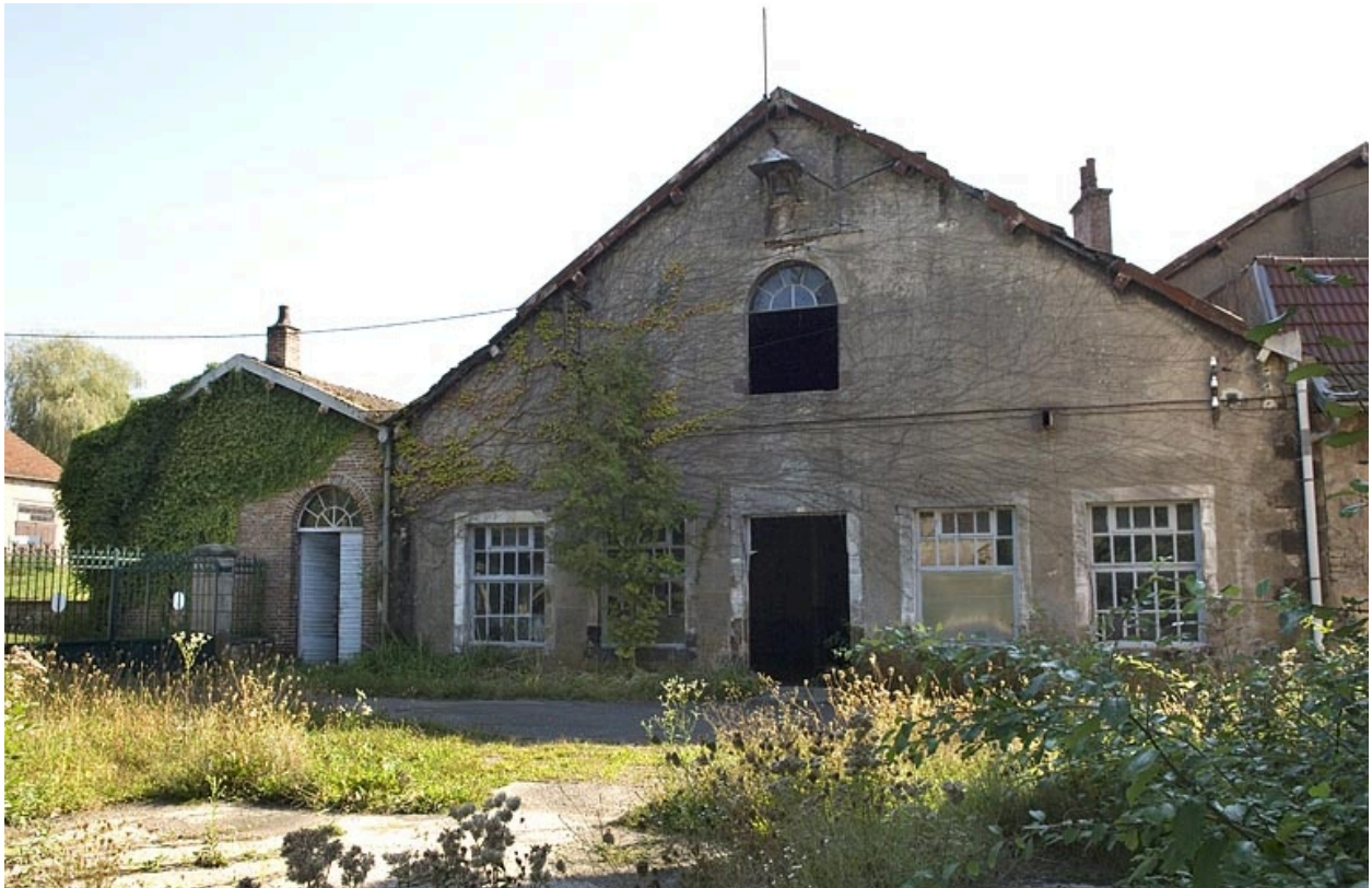
Pignon de l'atelier de réparation.
