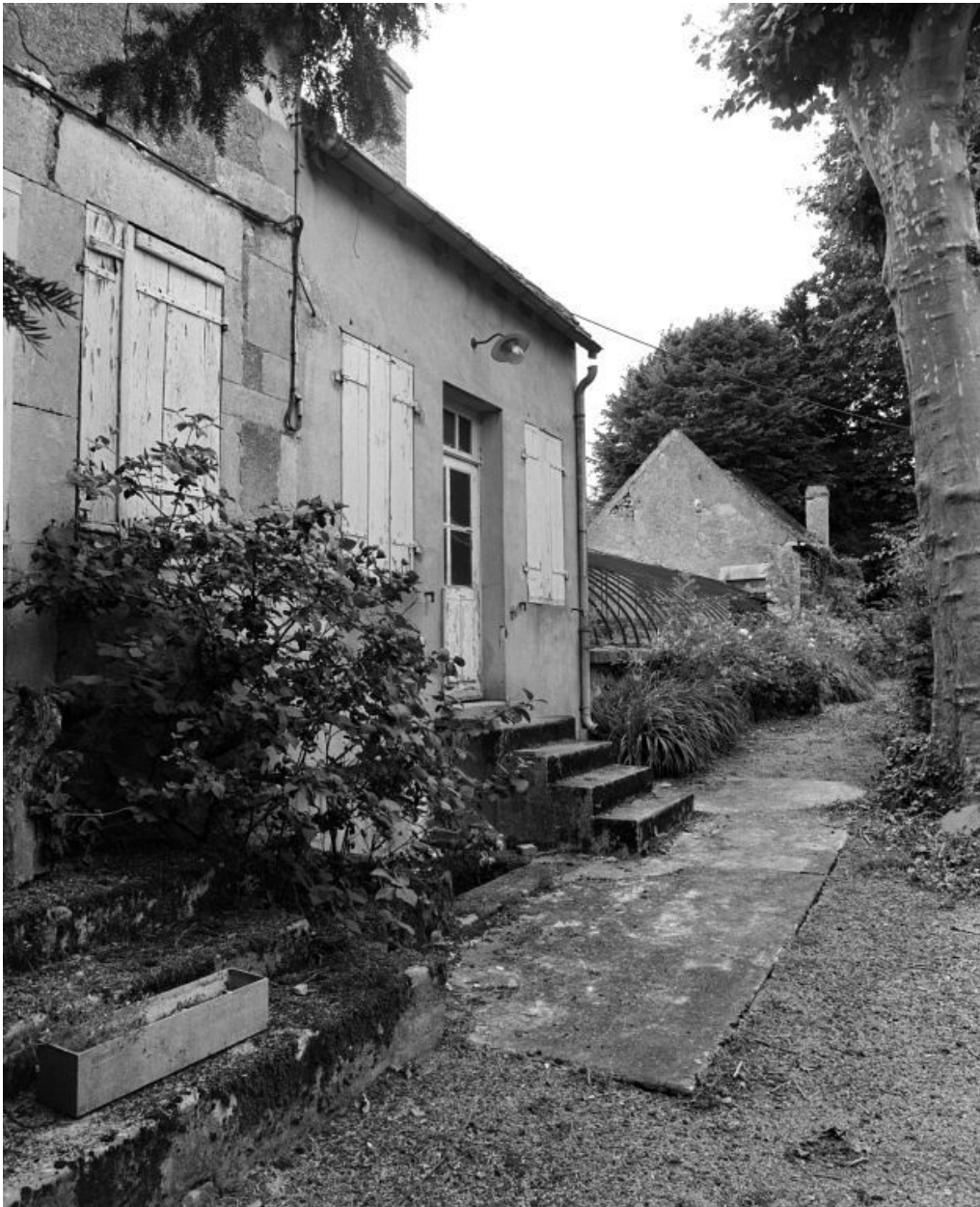
Logis annexe, serre adossée et chambre à four.
