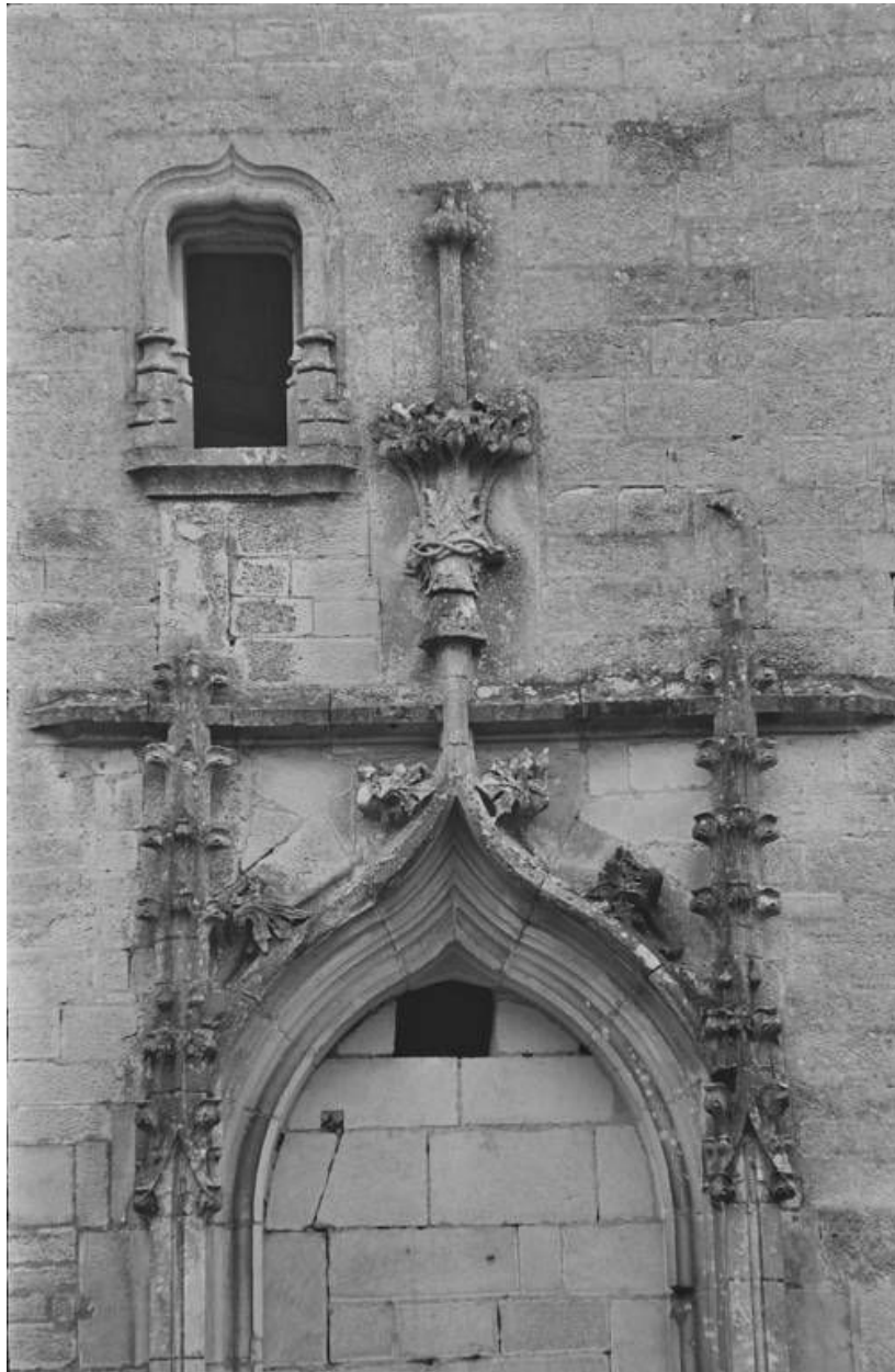
Porte principale du logis des Hôtes : détail des pinacles (photo prise en 1969).
