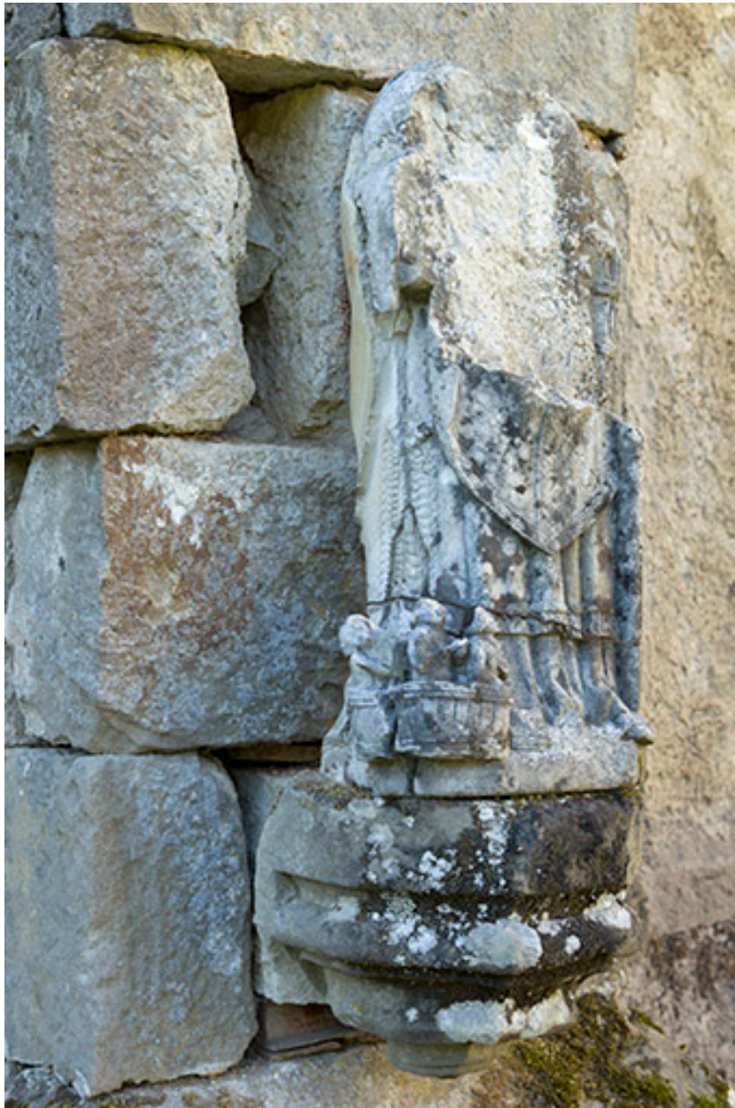
Fragment de sculpture le long du mur extérieur nord.
