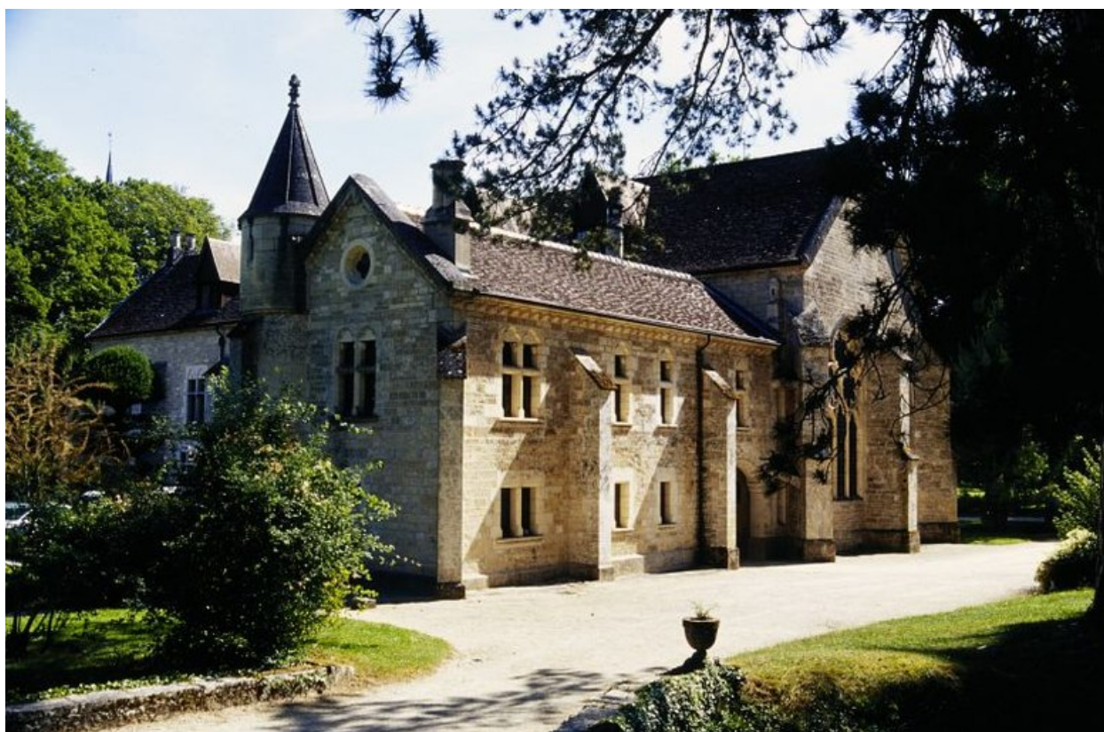
Le bâtiment du réfectoire et l'aile en retour.
