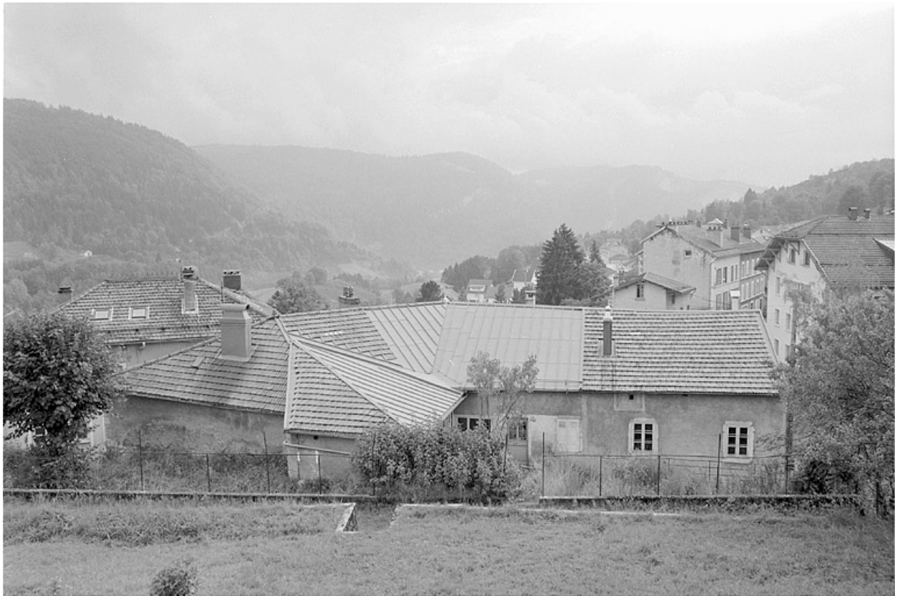
Façade postérieure et toit du bâtiment.
