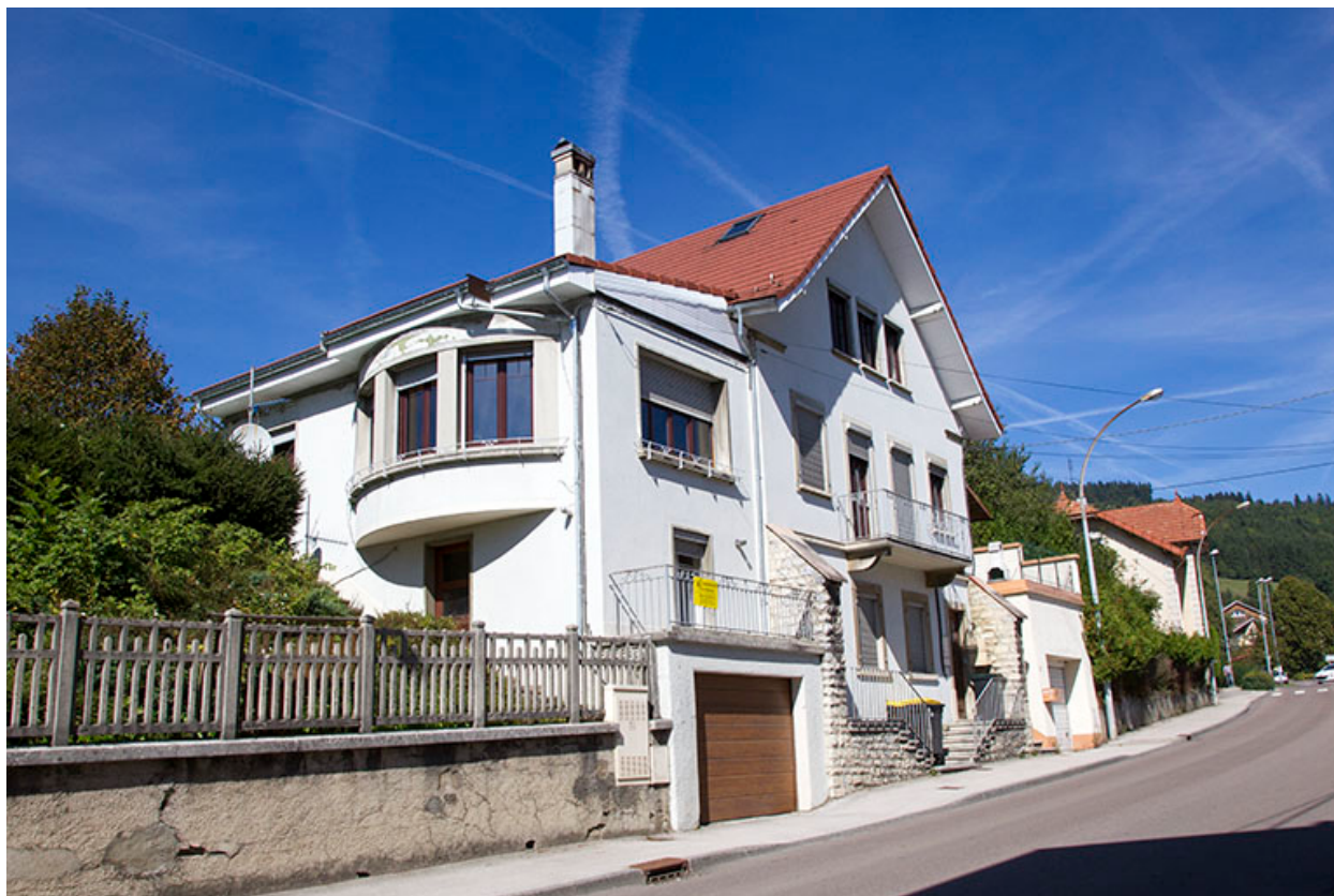
Façades antérieure et latérale gauche.
