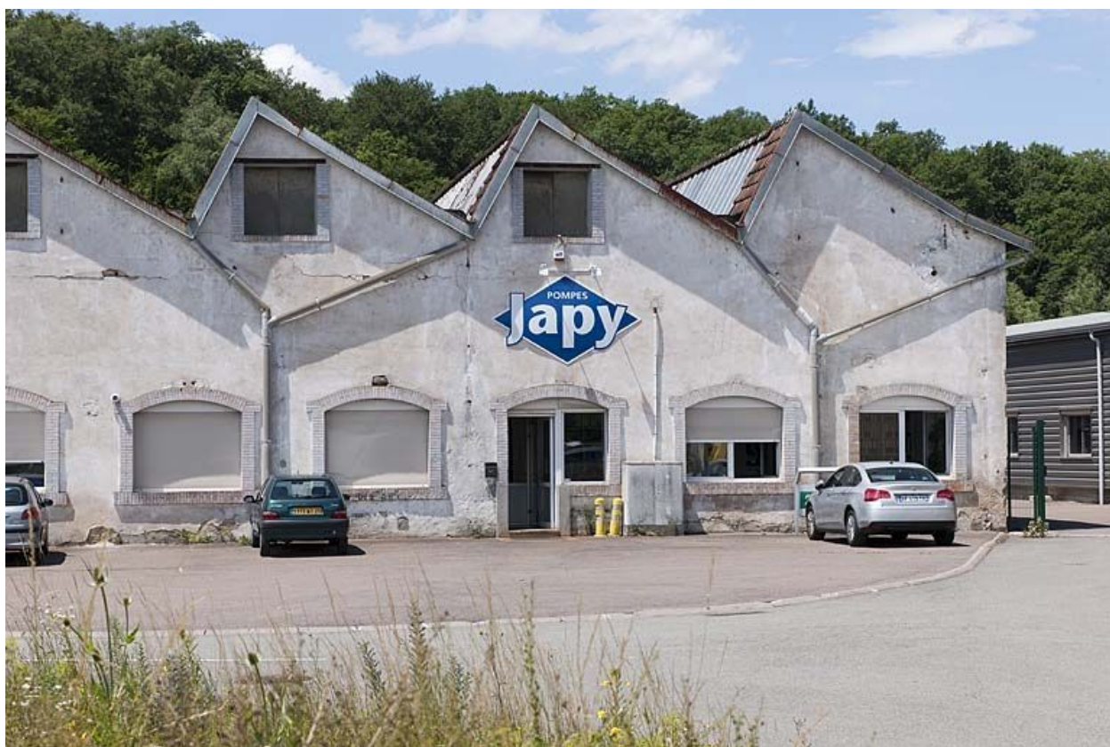
Atelier de fabrication des pompes. Travées nord.
