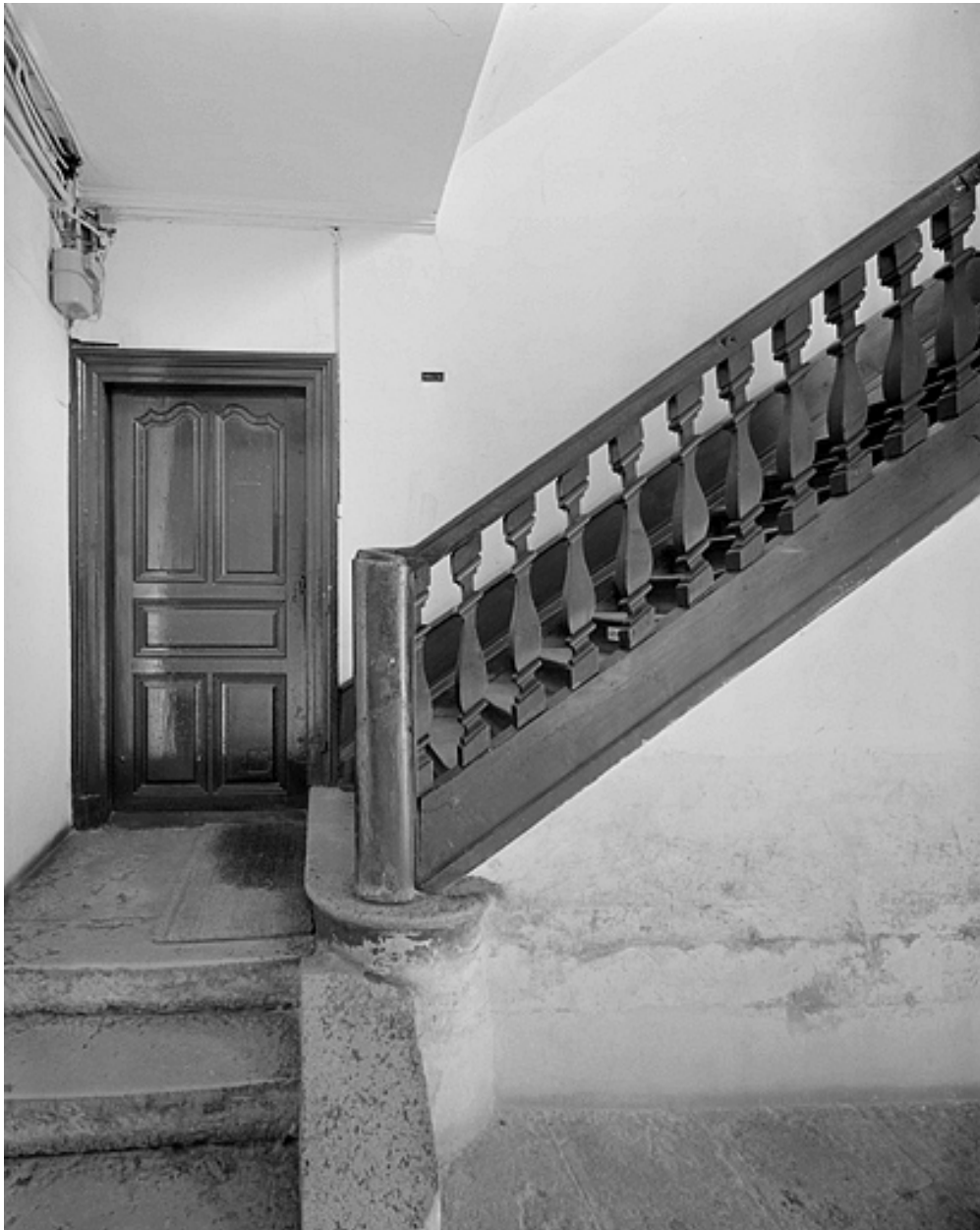
Escalier au niveau du rez-de-chaussée.
