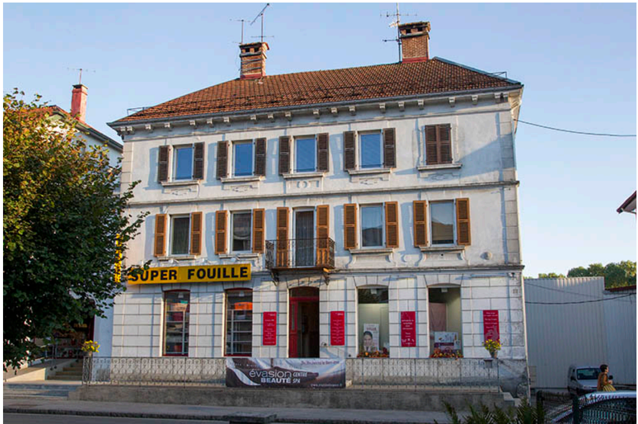
Immeuble au n° 13.
