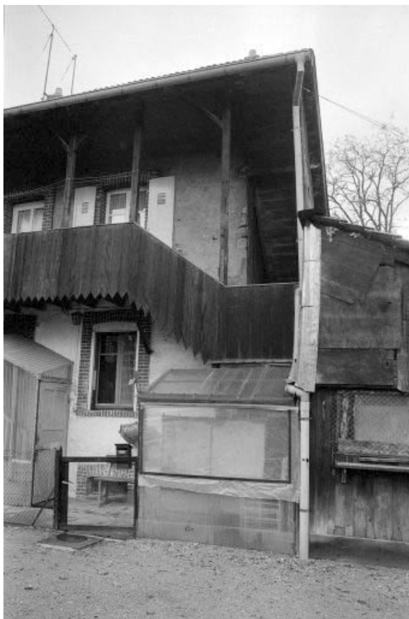
Façade postérieure : détail.
