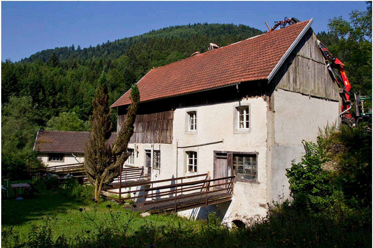
Scierie : façades postérieure et latérale gauche.
