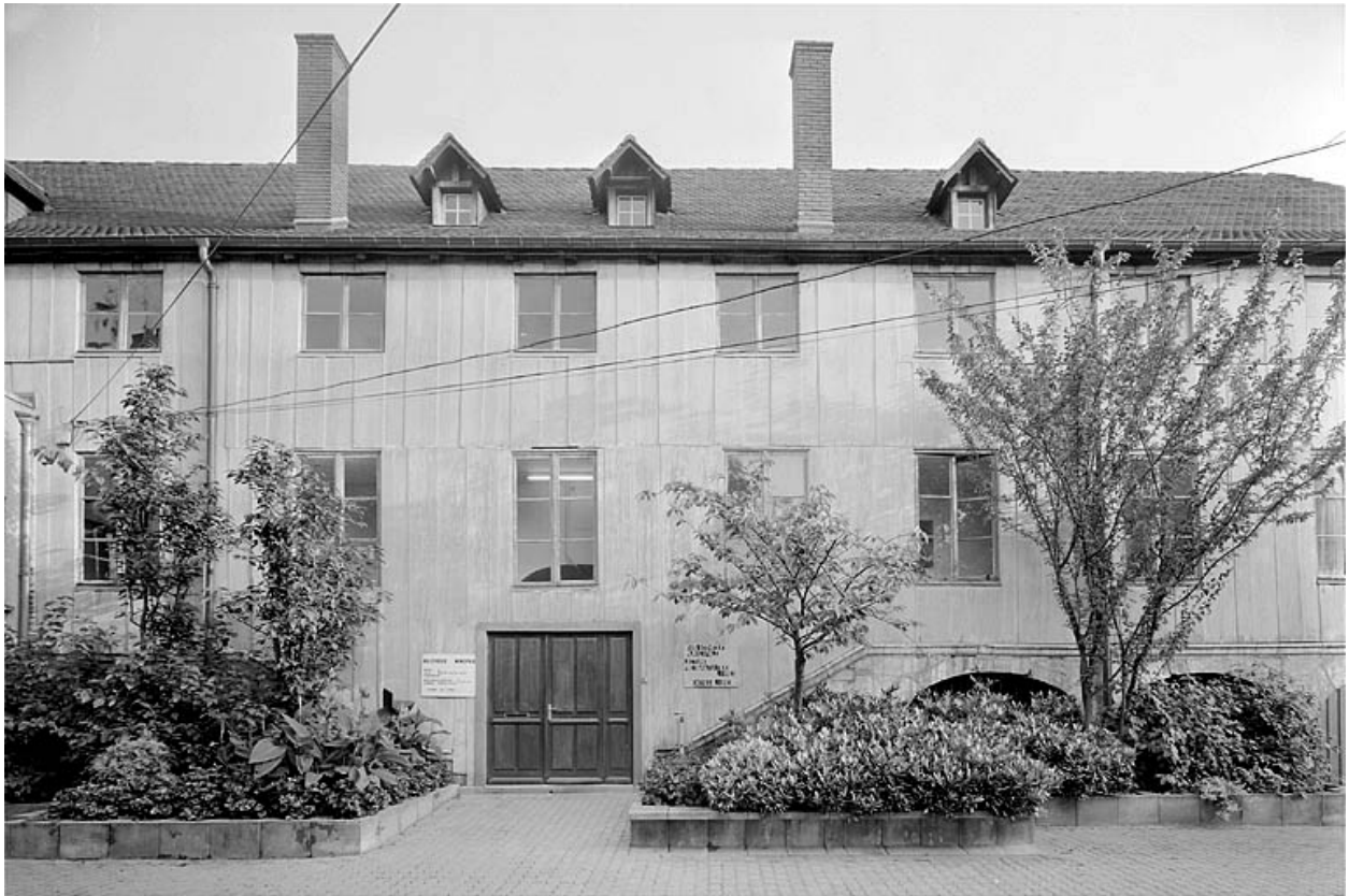
Façade sur cour.
