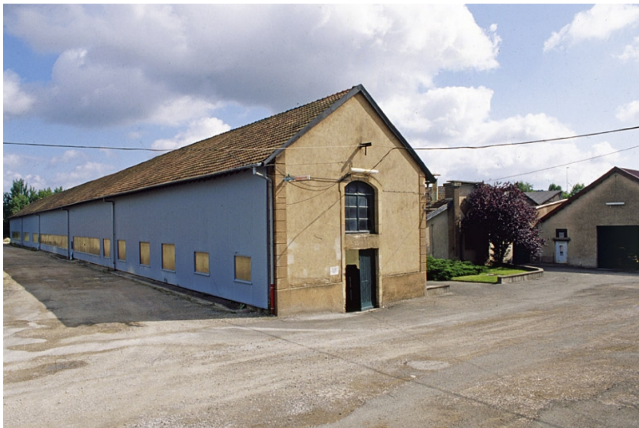
Atelier de fabrication (câblerie).
