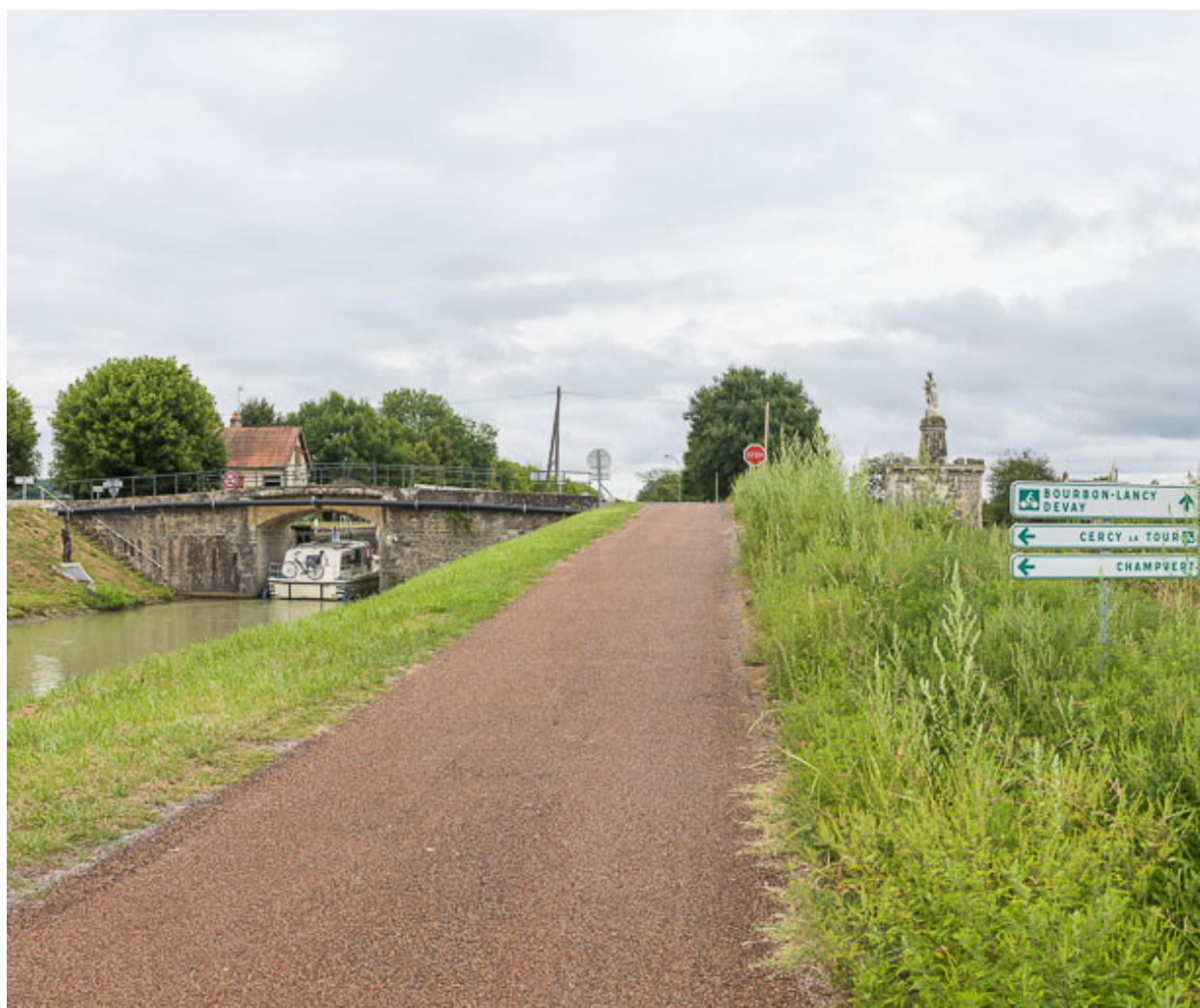
Vue du pont et du site.
