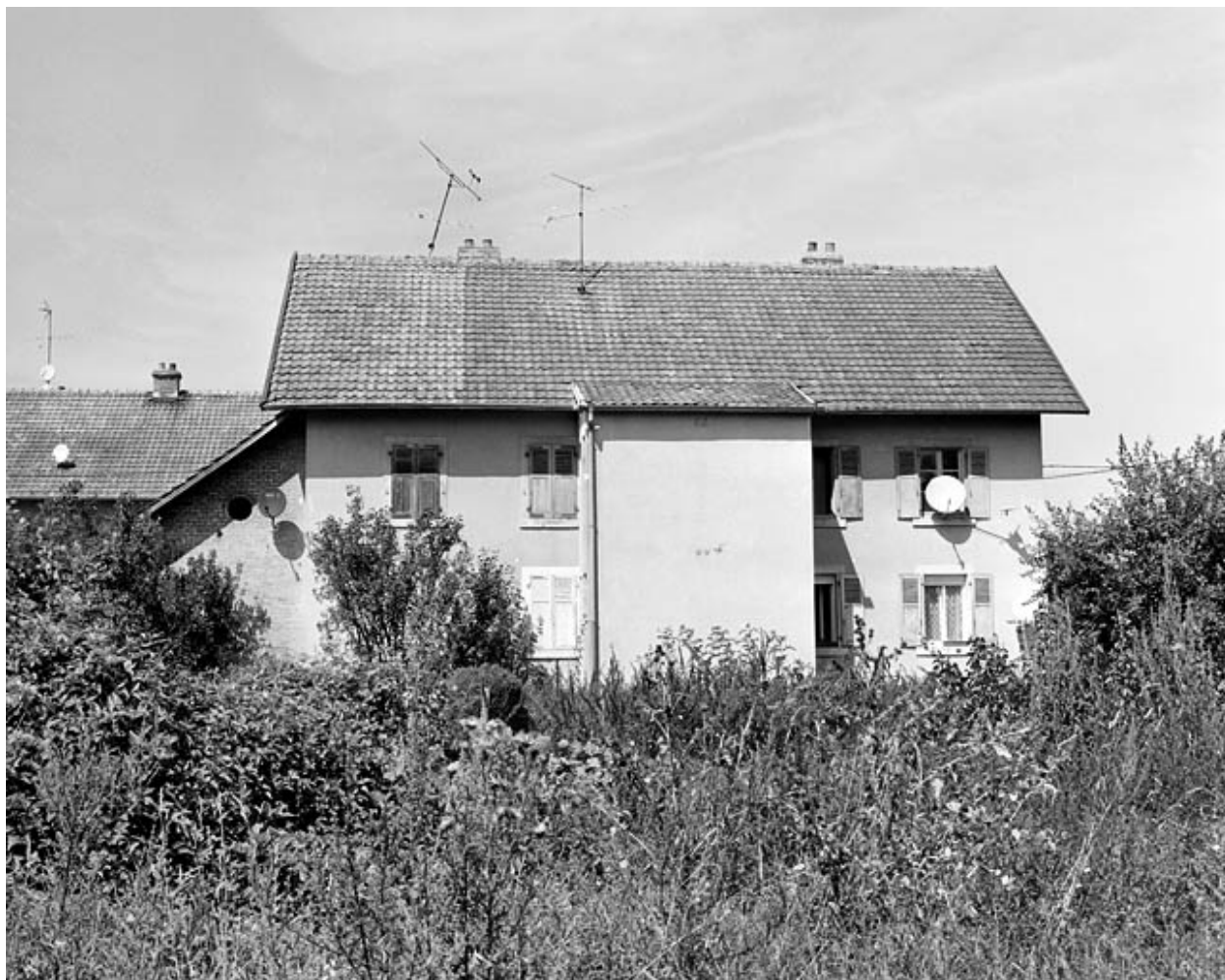
Façade postérieure d'un logement ouvrier collectif.
