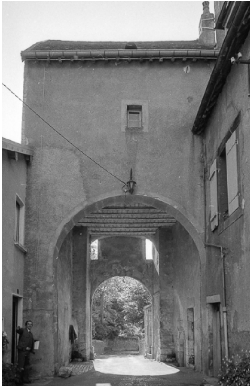
Ouvrage d'entrée : façade sur cour.
