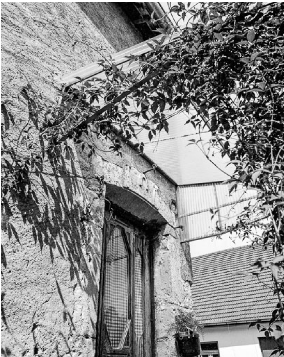
Maison située rue de Montbozon : détail de la porte d'entrée.
