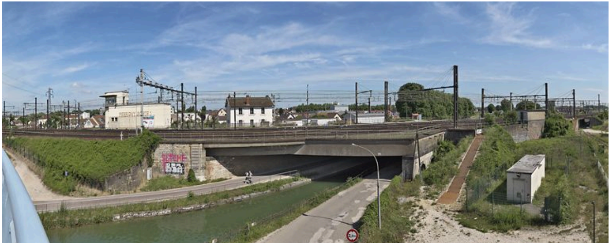
Pont ferroviaire isolé à Dijon.
