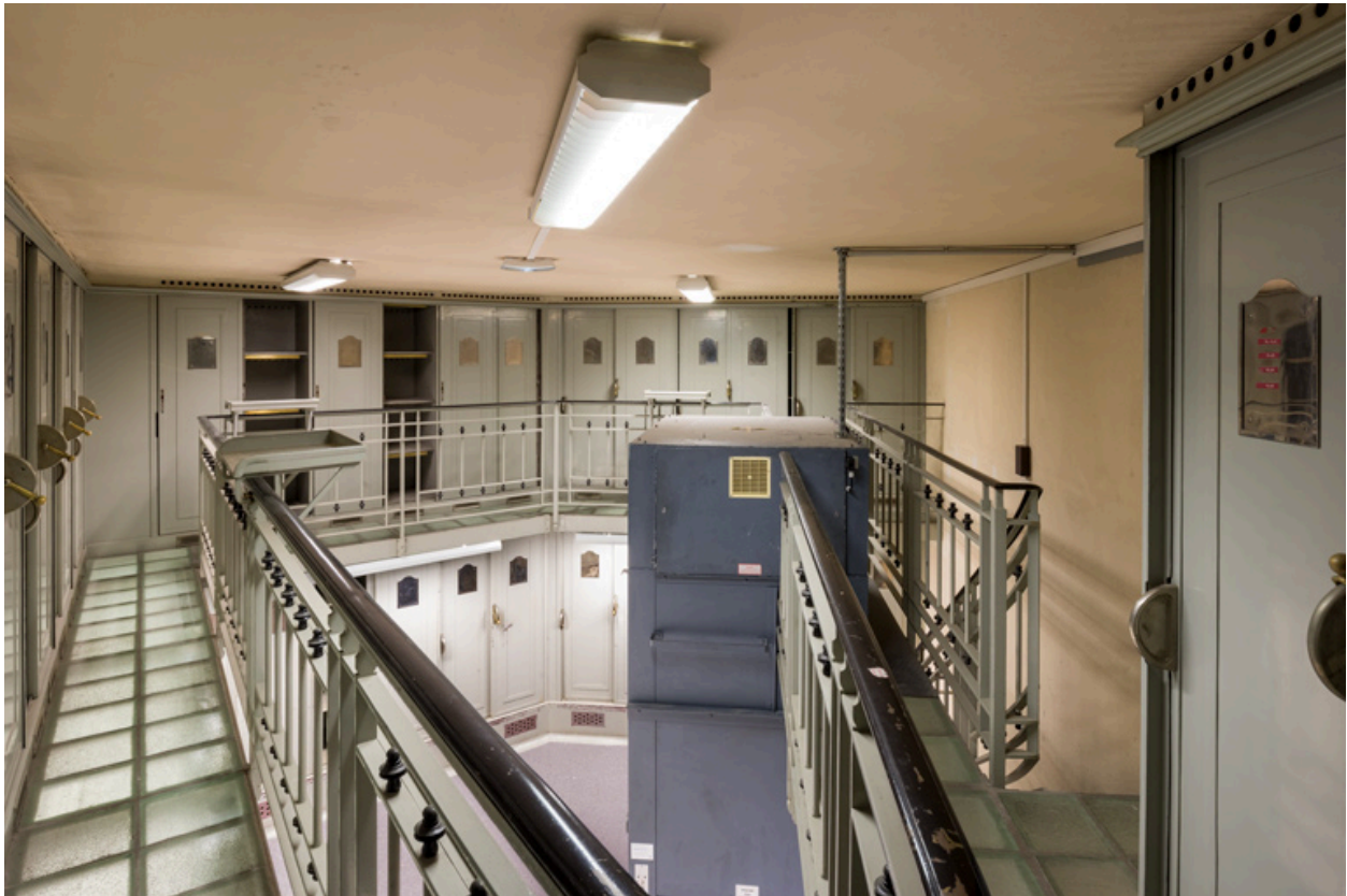
Rez-de-chaussée, caisse auxiliaire, galerie.
