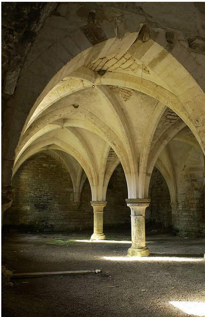
Cellier : rez-de-chaussée, salle sud vue depuis la porte ouest.
