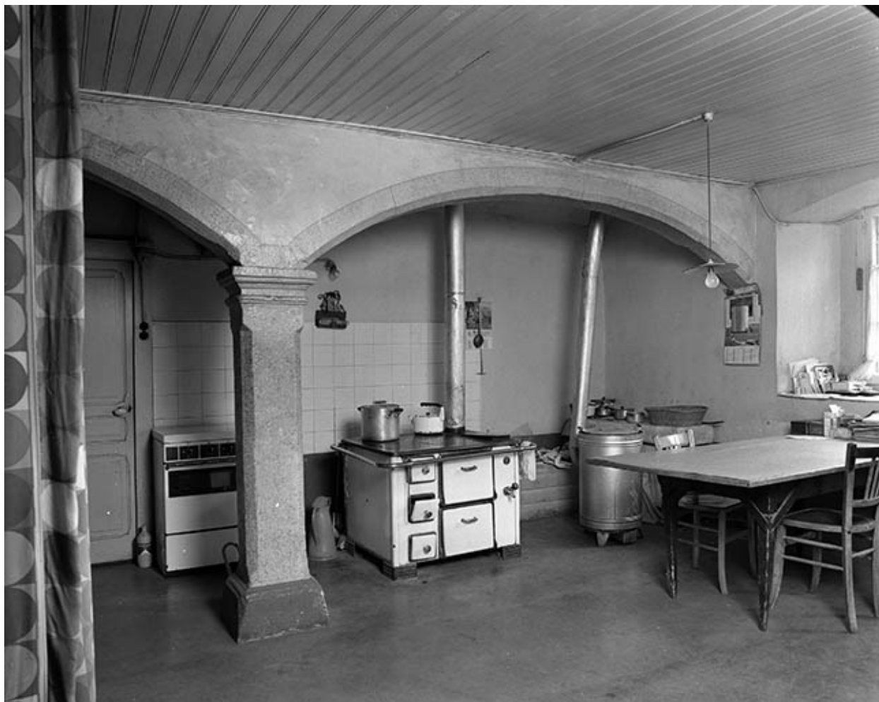
Cheminée de la première cuisine.
