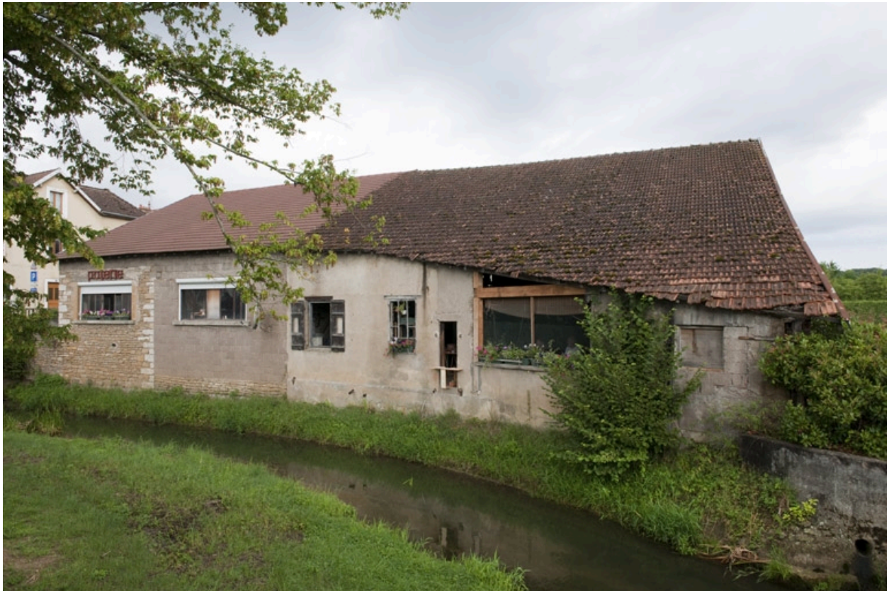
Atelier rue Léon Belz : façade postérieure, le long du Drigeon.
