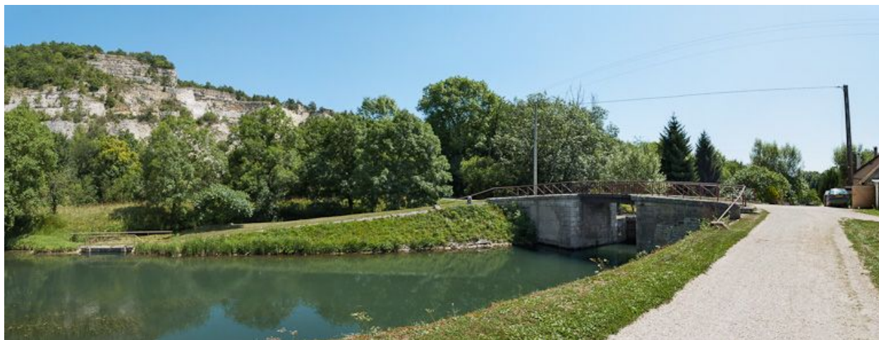
Pont vu d'aval.
