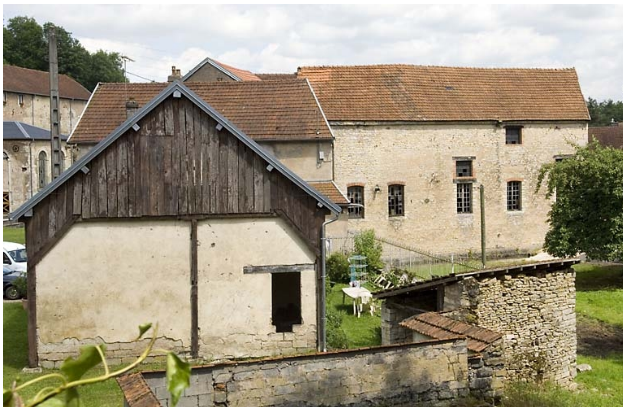
Façade est du magasin industriel.
