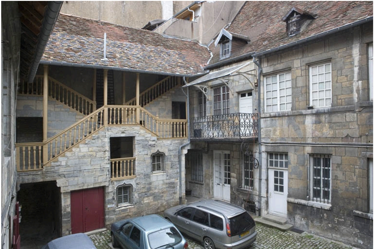
Vue d'ensemble de l'escalier à cage ouverte.
