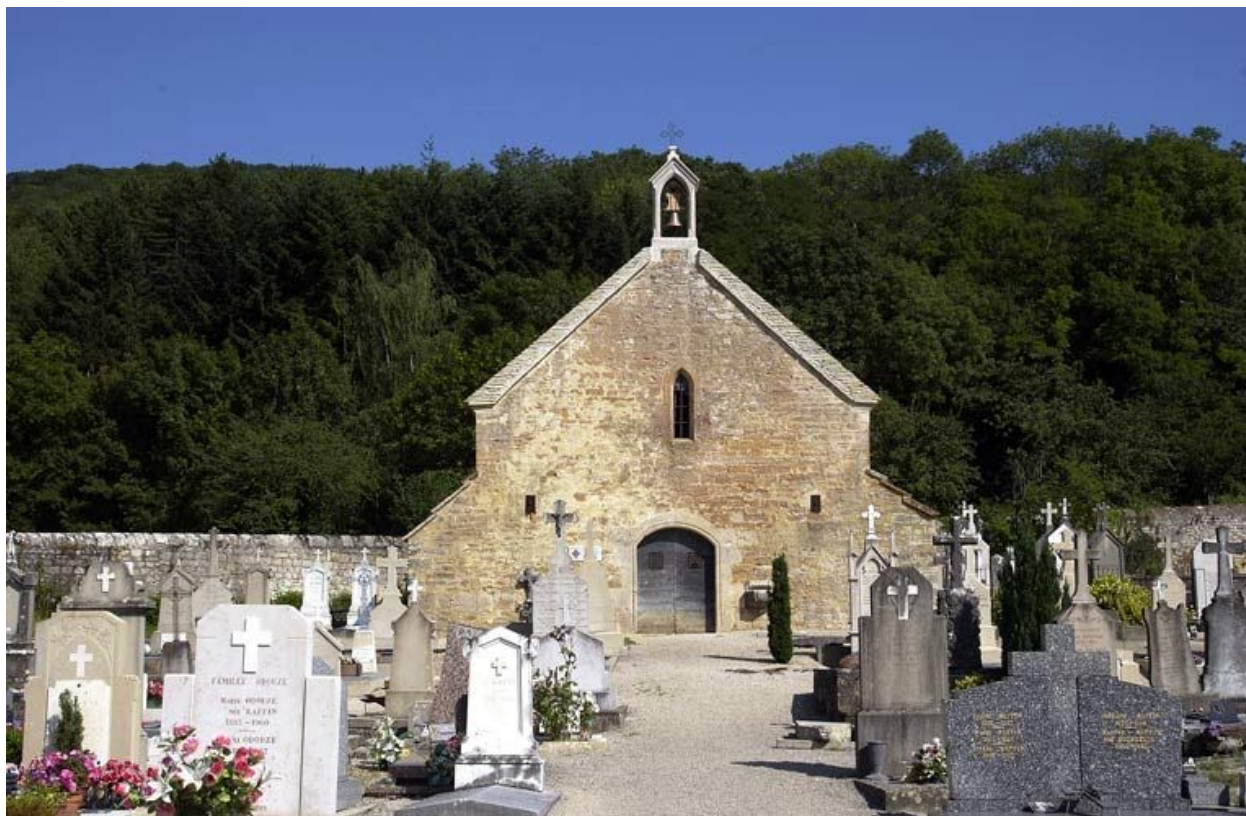
Façade antérieure de face.
