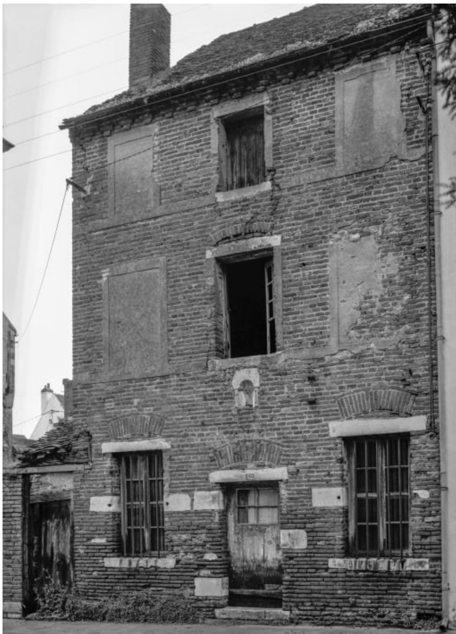
Façade d'une maison, 42 rue Dulac.
