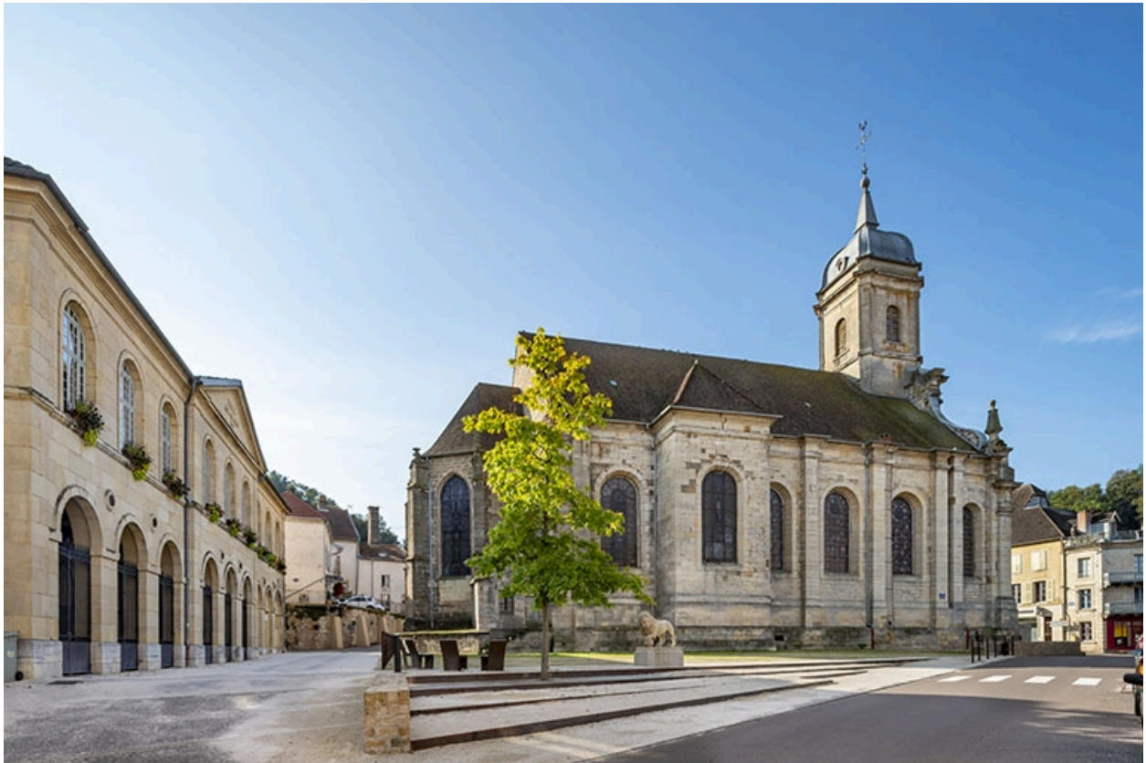
Flanc nord de l'église et façade de la halle aux grains.
