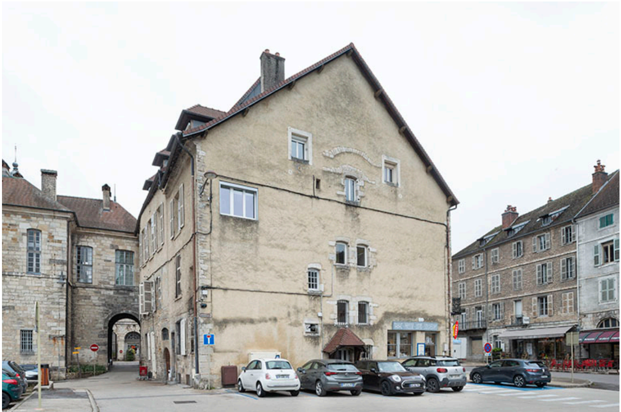
Mur pignon sud.
