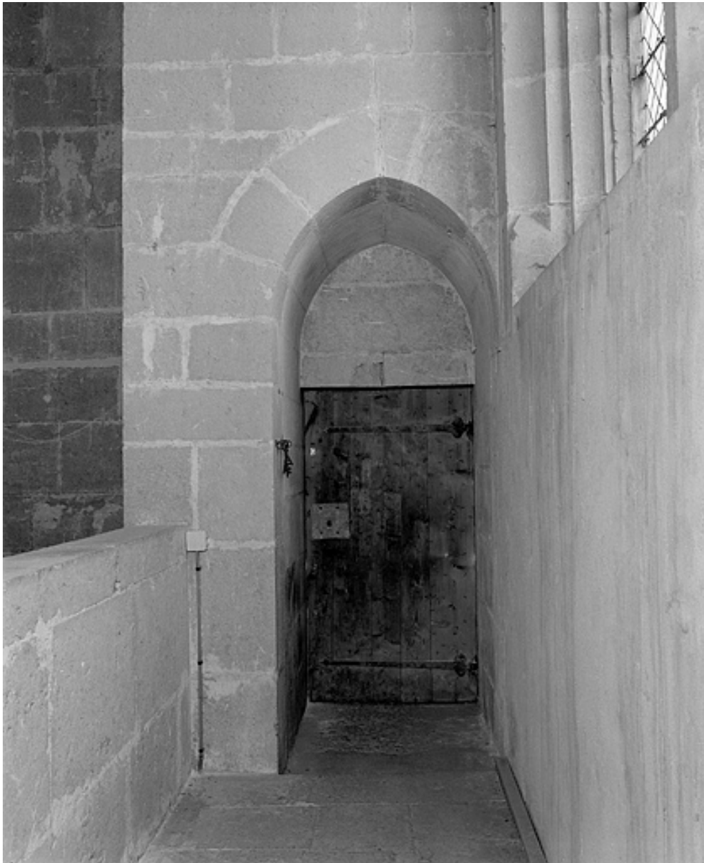
Entrée de l'ancien trésor.
