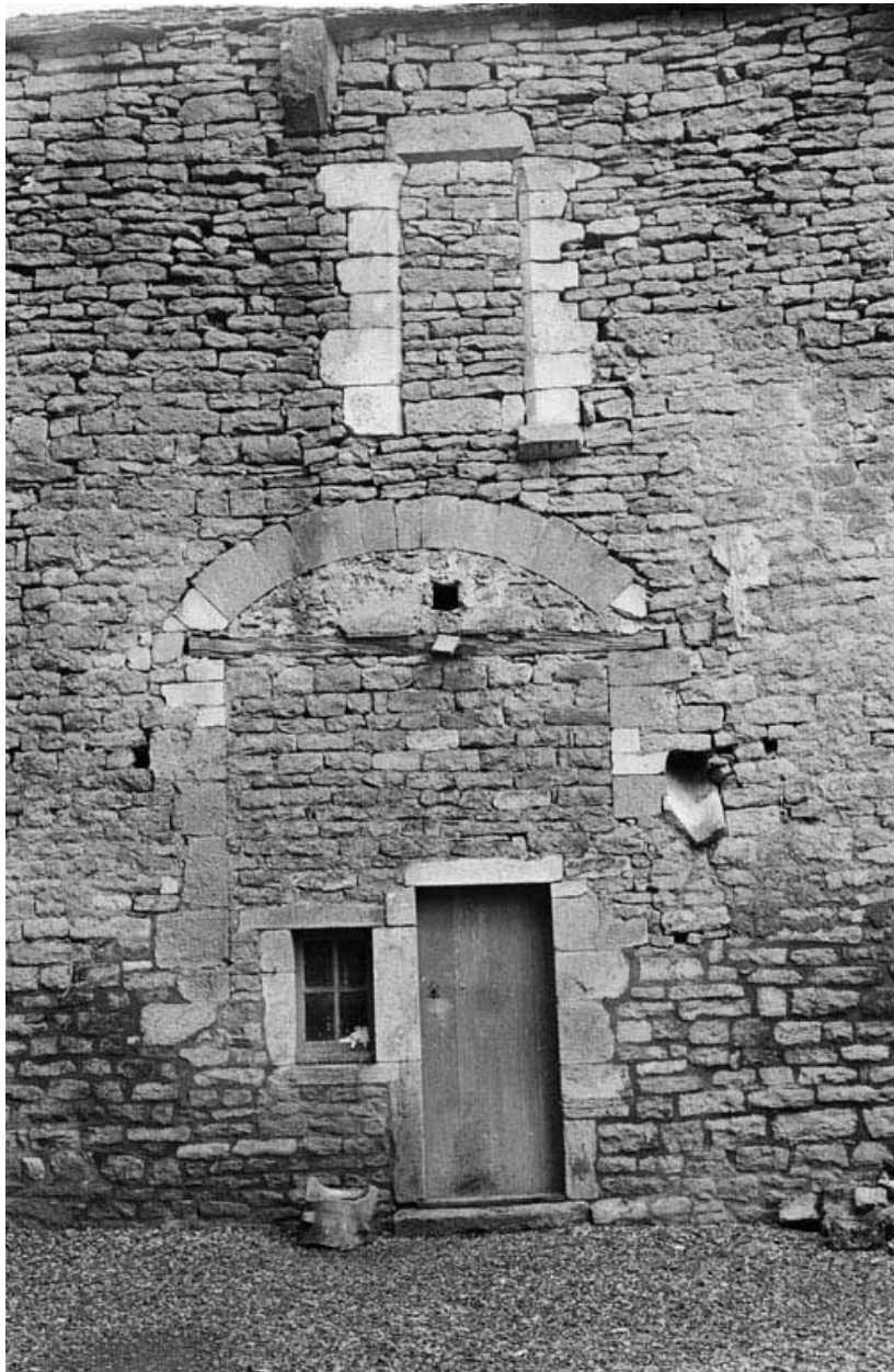
Courtine. Détail : les remaniements (photo prise en 1969).
