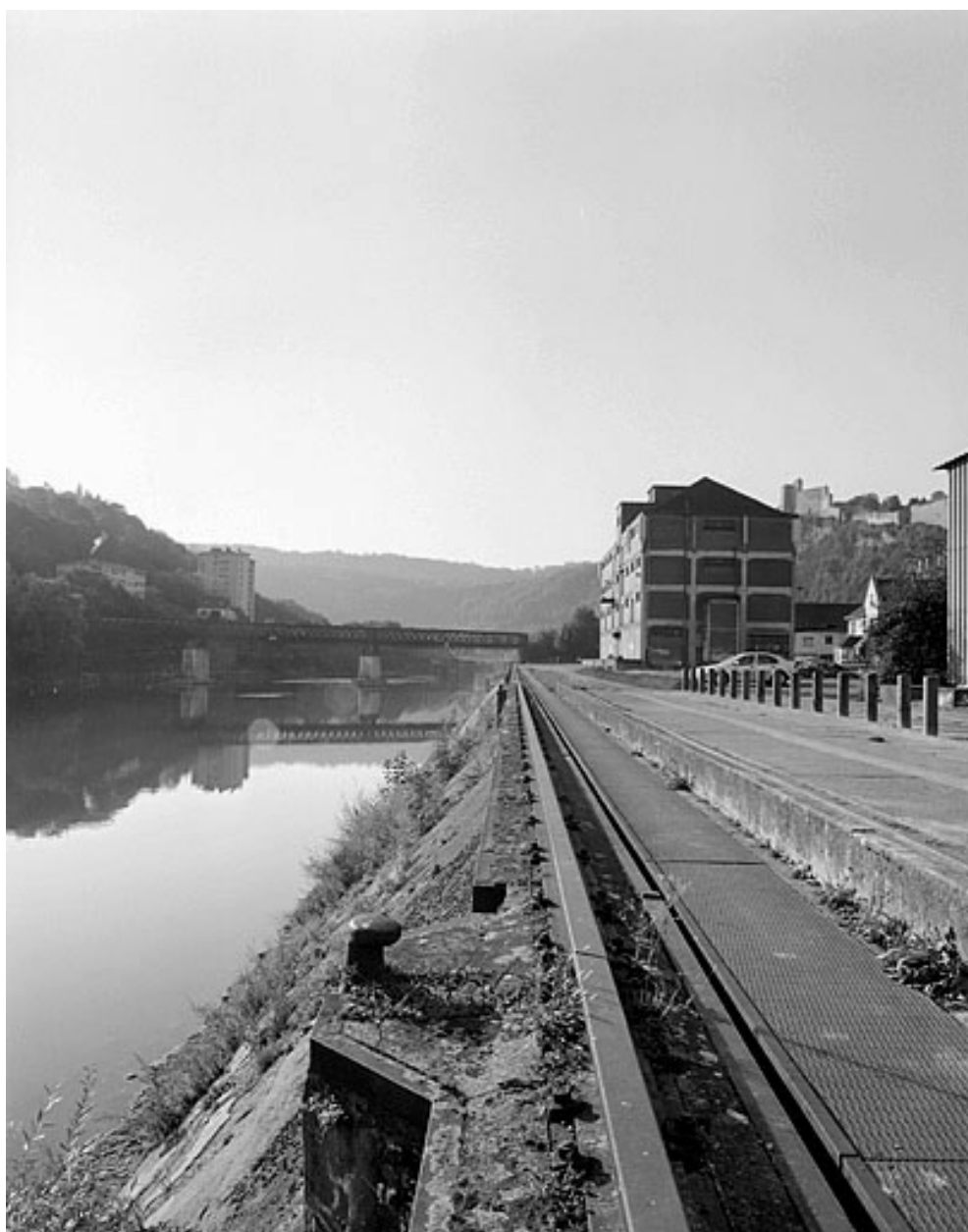
Entrepôt et quai, depuis l'aval.
