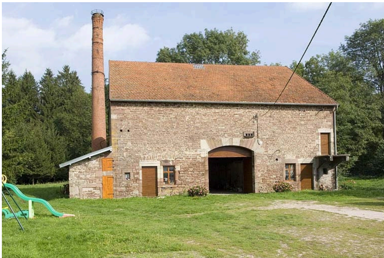
Atelier de fabrication (fabrique de colle). Façade antérieure.
