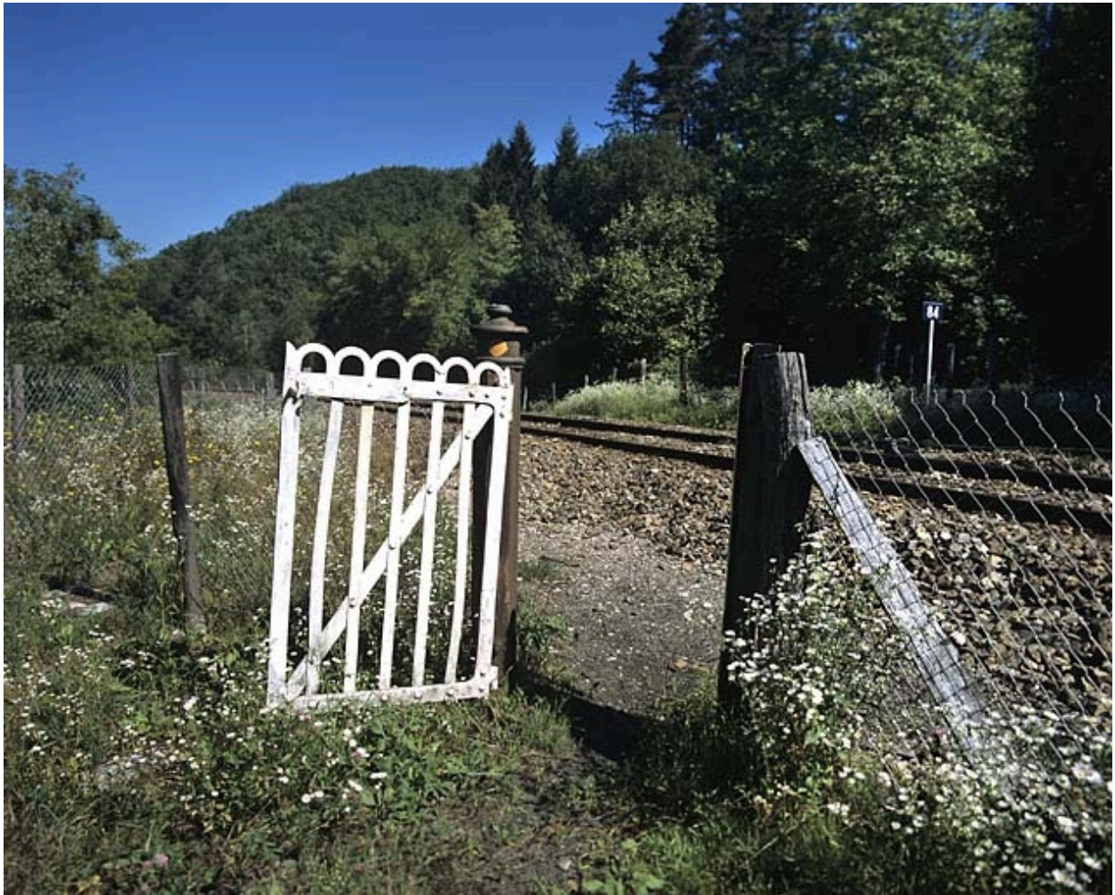
Portillon pour piétons, côté gauche de la voie.
