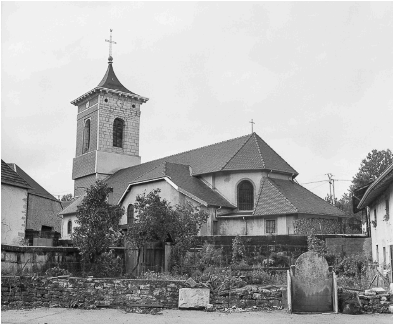
Extérieur : face latérale sud en 1976.
