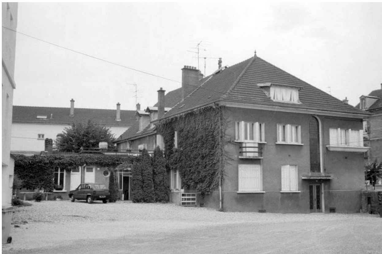
Logement patronal, vu depuis la cour.
