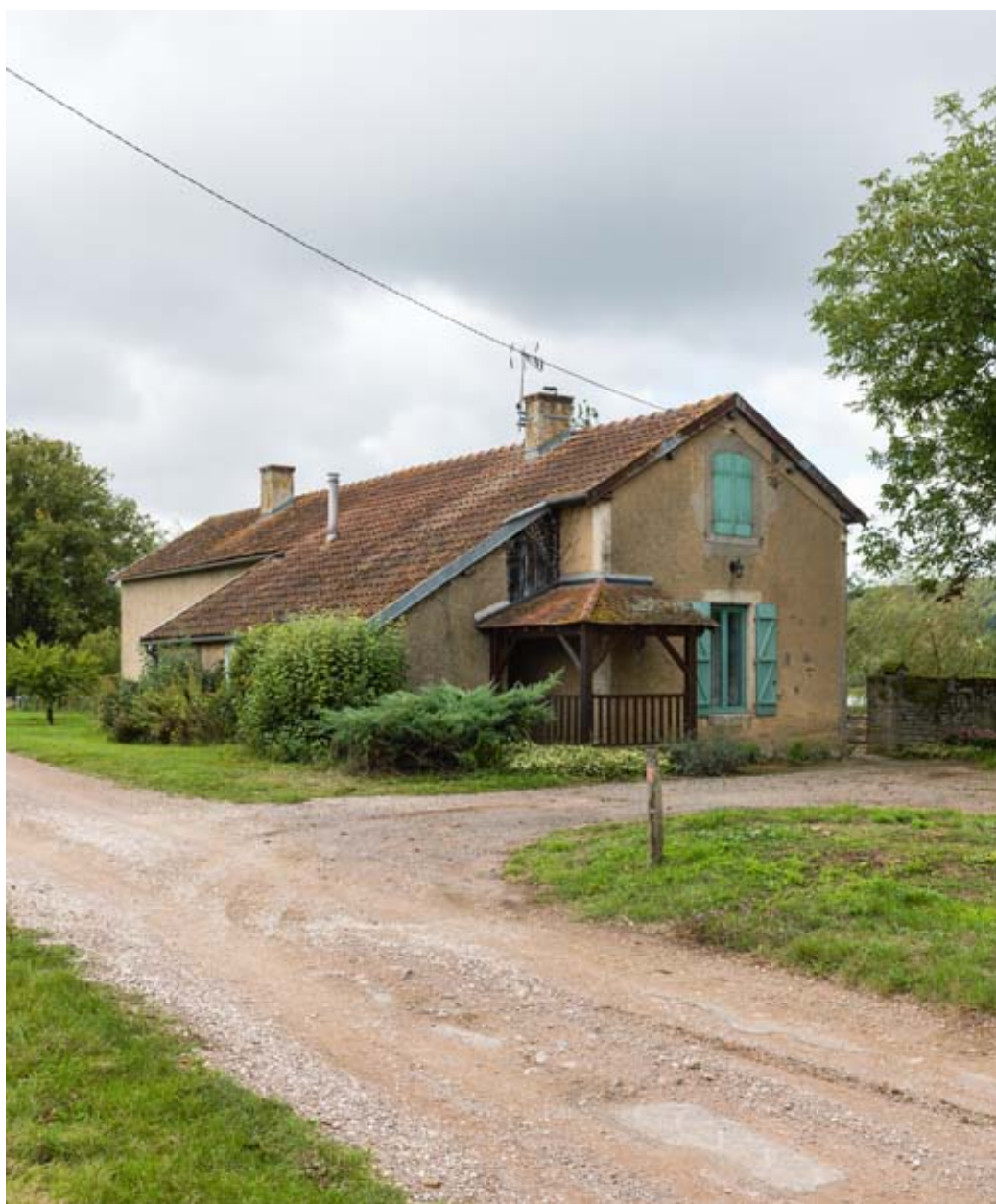
Vue rapprochée de la maison.
