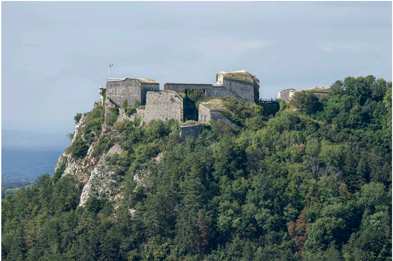
Fort Belin : vue générale du front sud.
