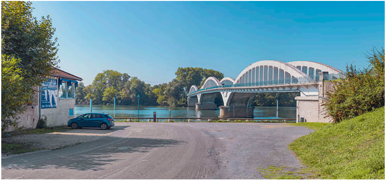
Le pont de Thoissey, vu d'aval, rive gauche.
