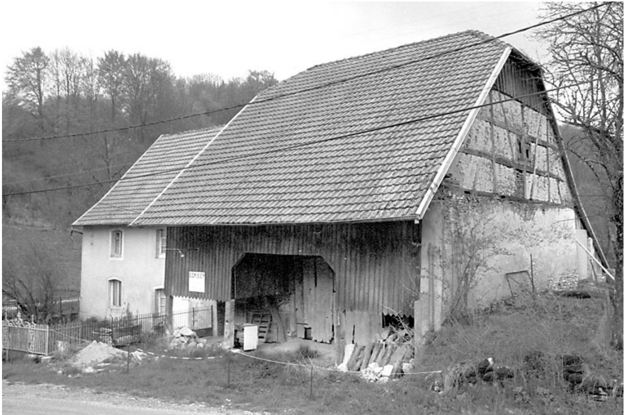
2e ferme : vue d'ensemble.
