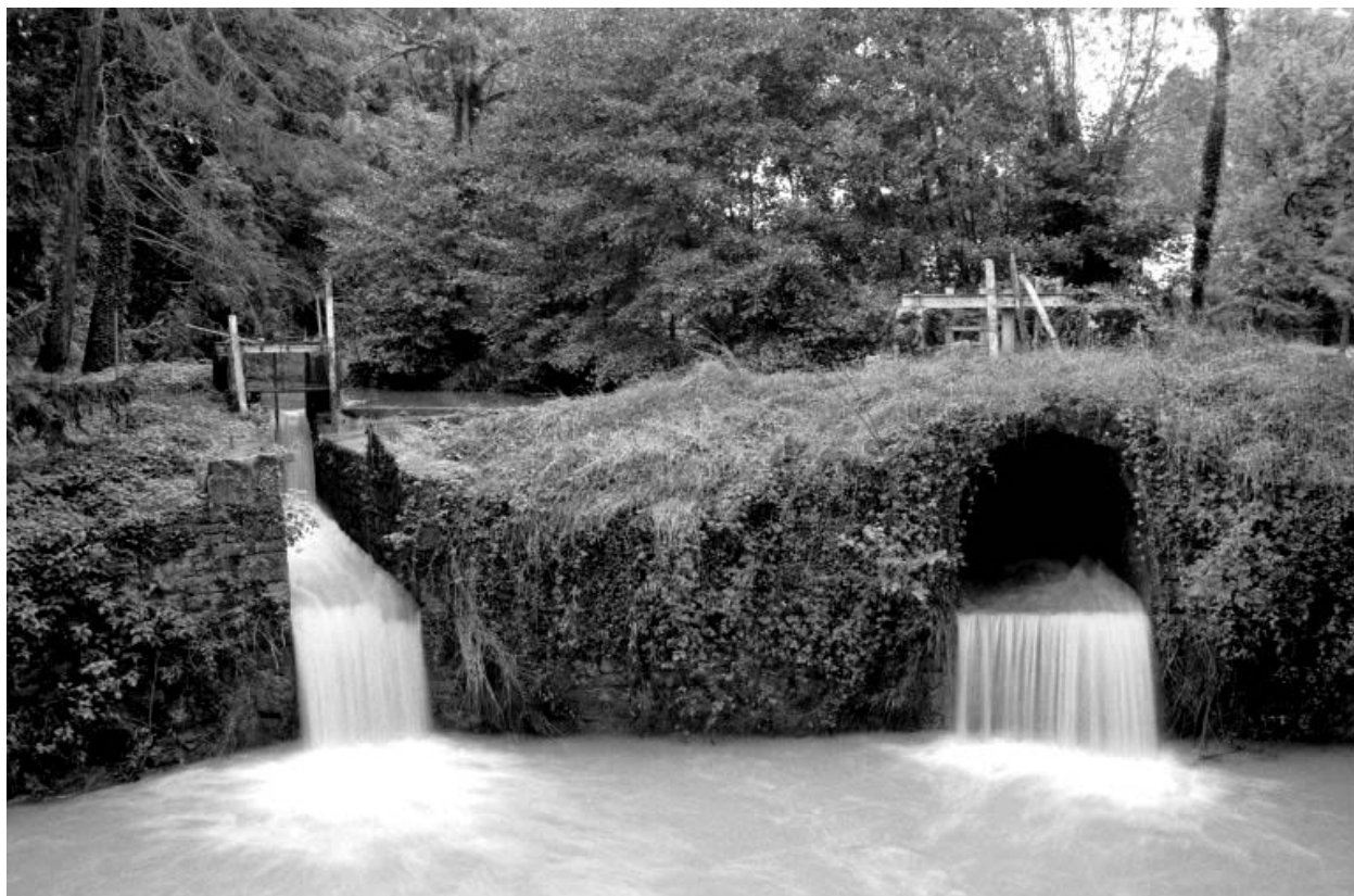
Vannes de décharge.
