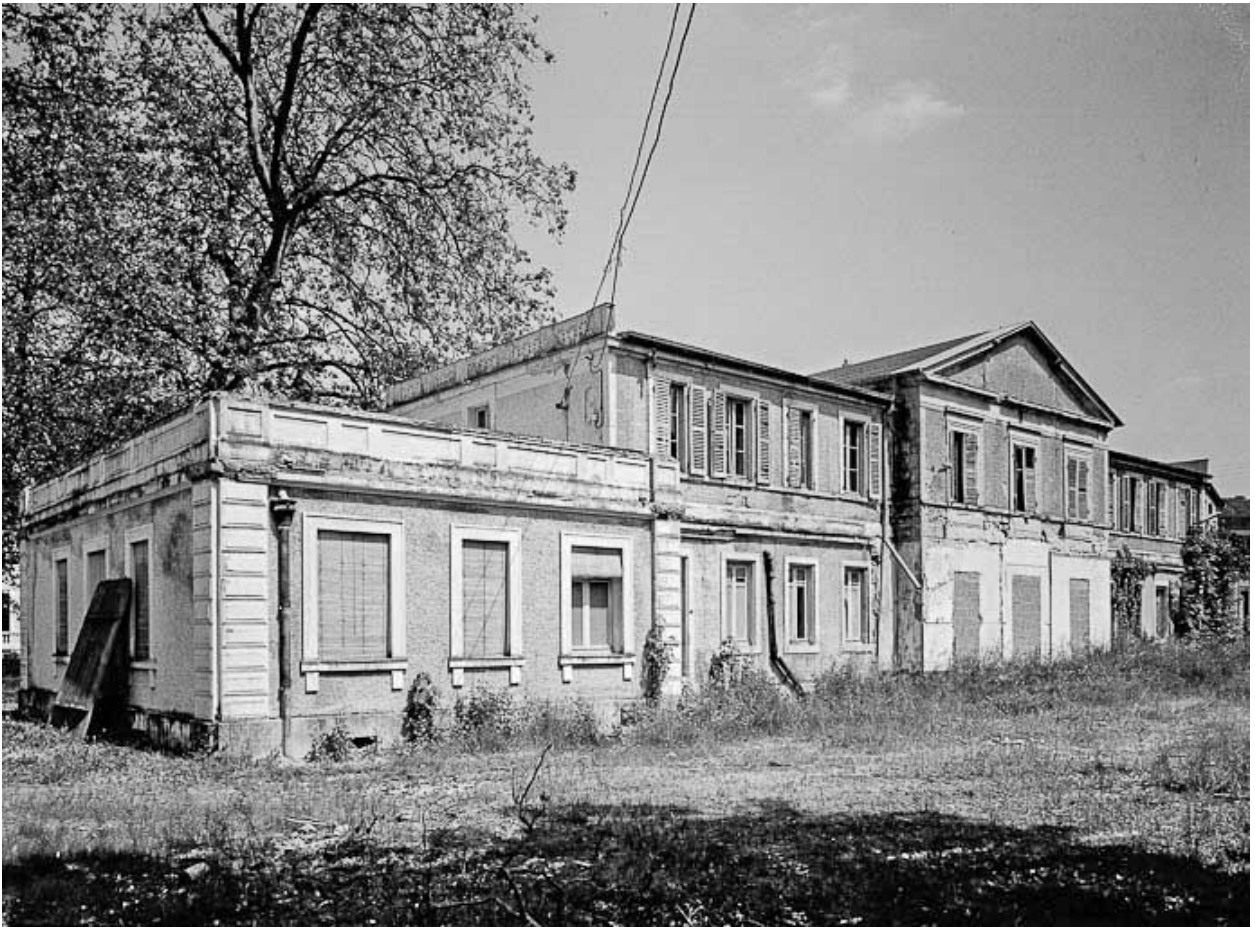
Façade postérieure, vue prise en 1984.
